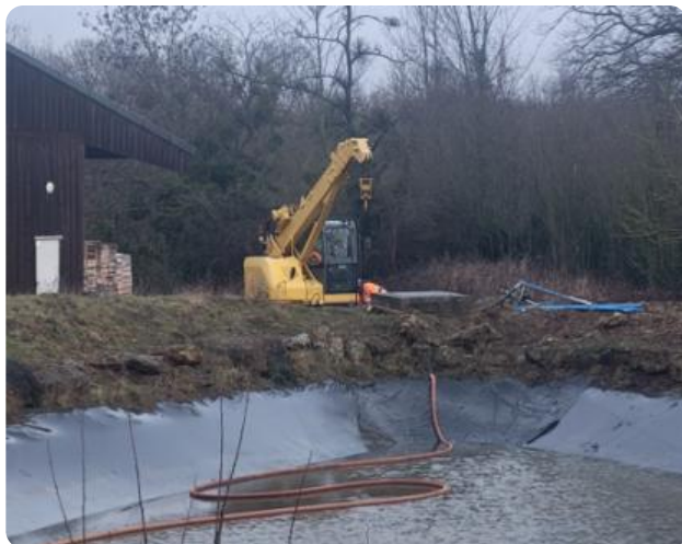
Maintenance du forage
